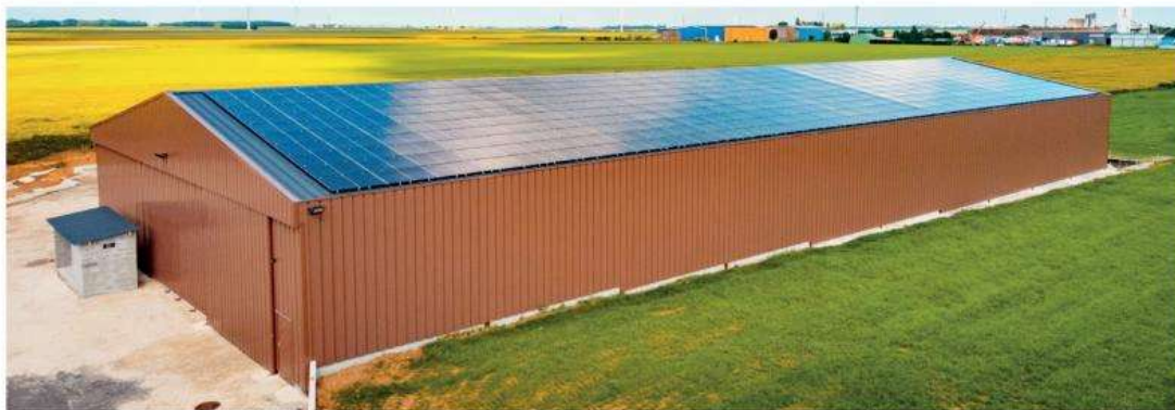
Réalisation d'un bâtiment agricole 270 kWc - Jarville-en-Beauce (28)
